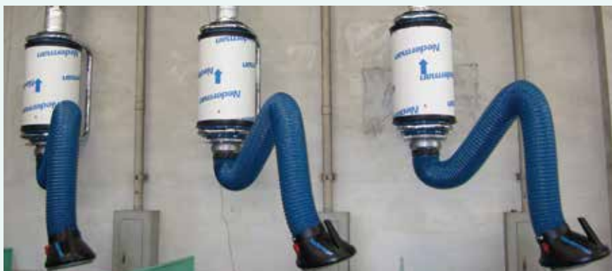
※写真のようにMFSの下部に直接取り付けられるアームは2m/3mまでになります。
